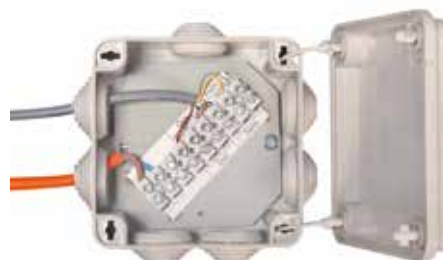
Boîtier avec les câbles
